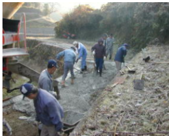
協定参加者による舗装作業
