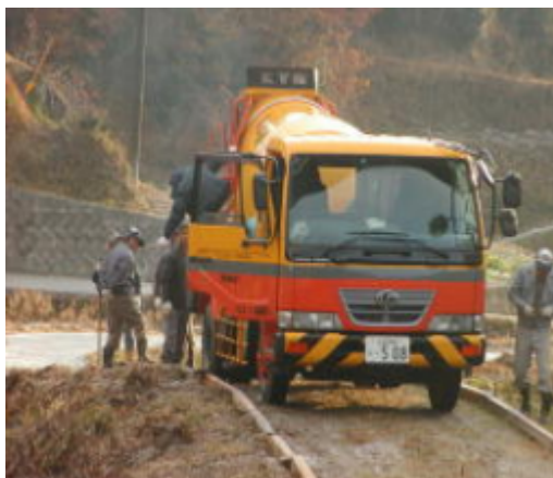
協定参加者による舗装作業
