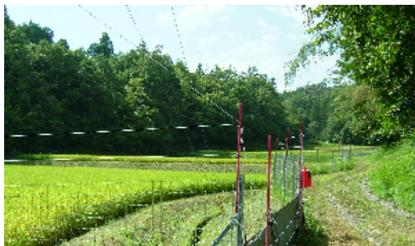
【防護柵の設置】
