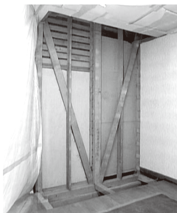
耐震改修中の住宅
