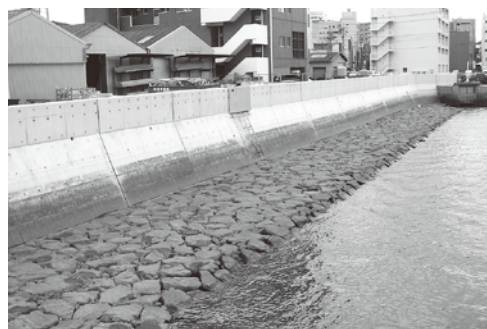
徳山下松港の護岸整備
