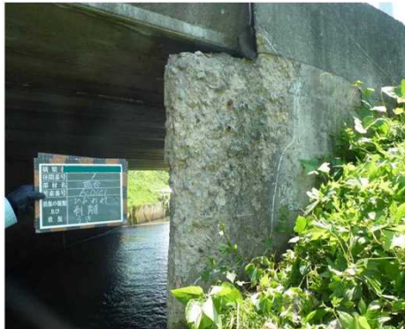
建設後33年経過。PC床版橋の下部工の剥離状況。
