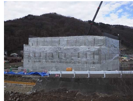
脱型後→ビニールシート養生
