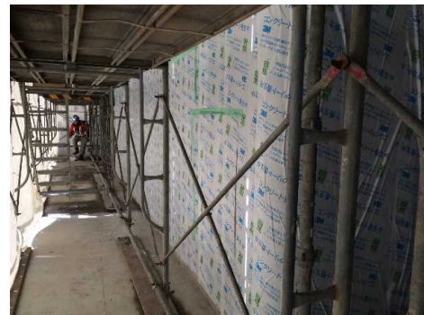
養生シートを使用した例
