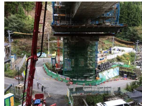
PC上部工のビニールシート 養生
