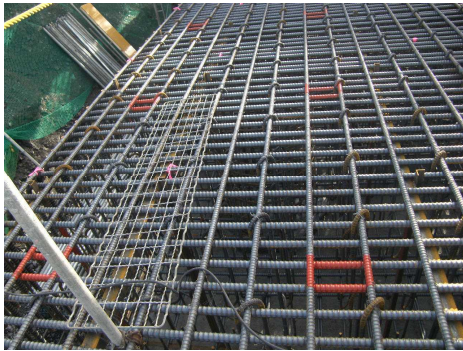
筒先の挿入口をマーキング
