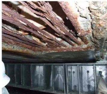
桁下面のPC鋼材の腐食、破断状況 硬化コンクリート中の空気量は約0%
