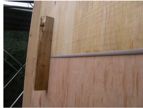
型枠継ぎ目にノロ漏れ防止テープ
