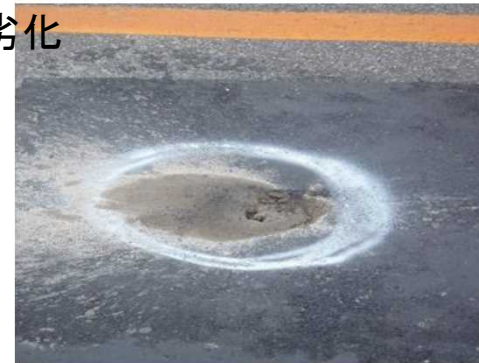
舗装から土砂が噴出している箇所の床版の状態 コンクリートの土砂化と鋼材腐食が見られる
