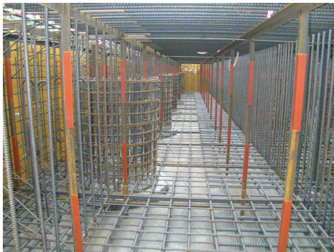
層厚管理のため組立架台に マーキング
