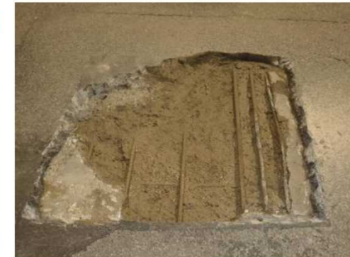
舗装から土砂が噴出している箇所の床版の状態 コンクリートの土砂化と鋼材腐食が見られる
