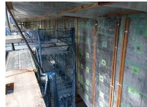
PC上部工のビニールシート 養生
