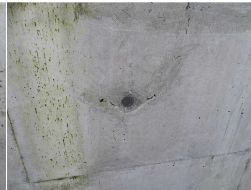
沈みひび割れ
