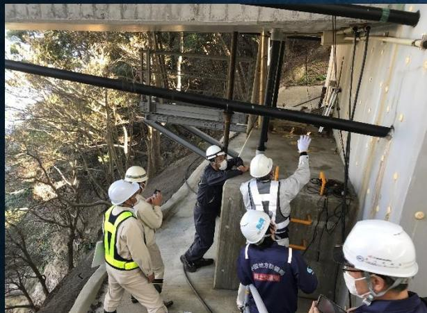
主桁-橋台連結工(負反力対策)
