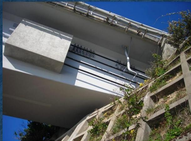
主桁-橋台連結工(耐震対策)
