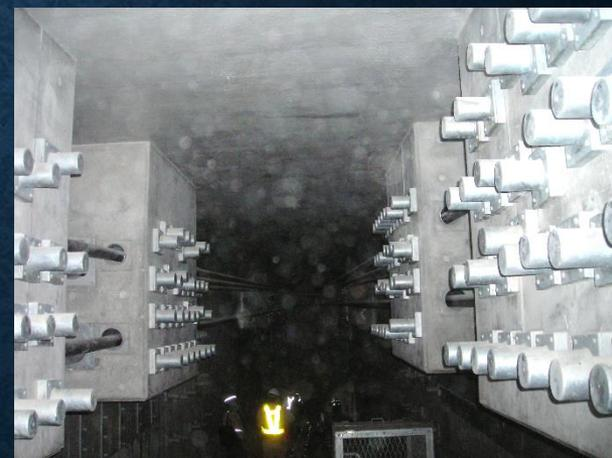
外ケーブル補強工(車両大型化)
