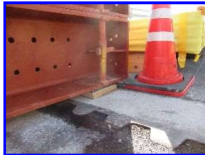
【桁押さえ部の状況】 ・ 緩衝ゴムとH鋼の隙間：1~2mm
