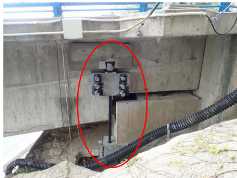
バックアップ部材の設置例
