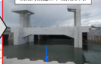
高潮対策施工中(防潮水門)
