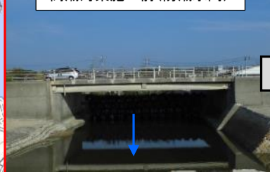
高潮対策施工前(防潮水門)
