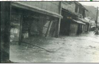
昭和29年9月洞爺丸台風 浸水状況（琴橋付近）
