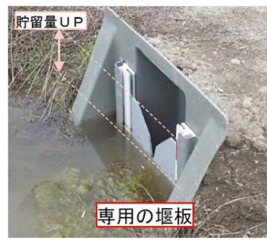
田んぼダム用堰板の例
