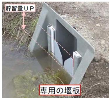
大雨時に排水口に流出量を抑制するための堰板を設置し、雨水貯留能力を人為的に高め、河川や水路の水位の急上昇を抑制
