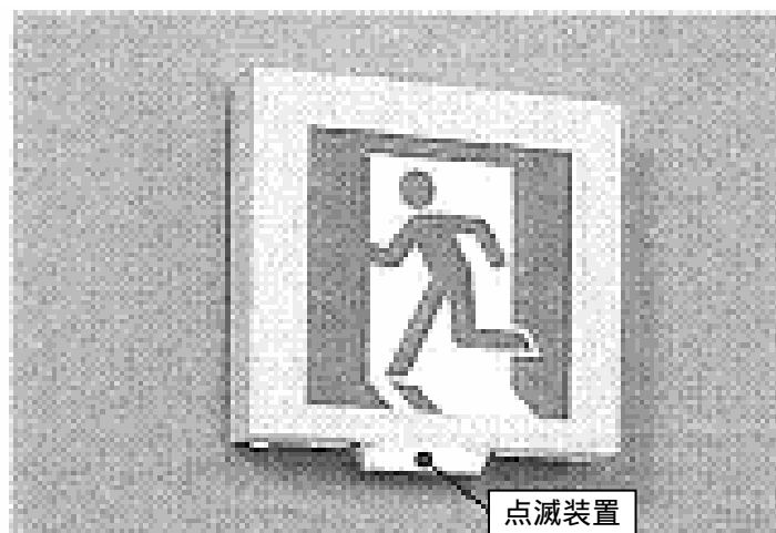
点滅型誘導灯(電池内蔵型)
