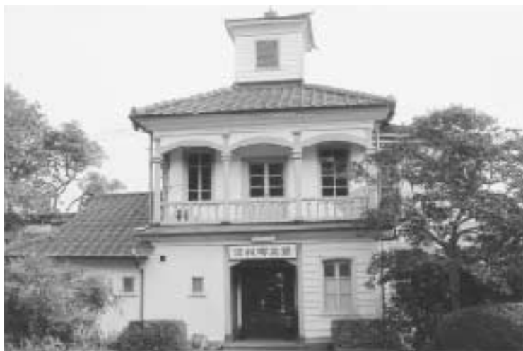
写真2 旧松原写真館正面（平成18年撮影）
