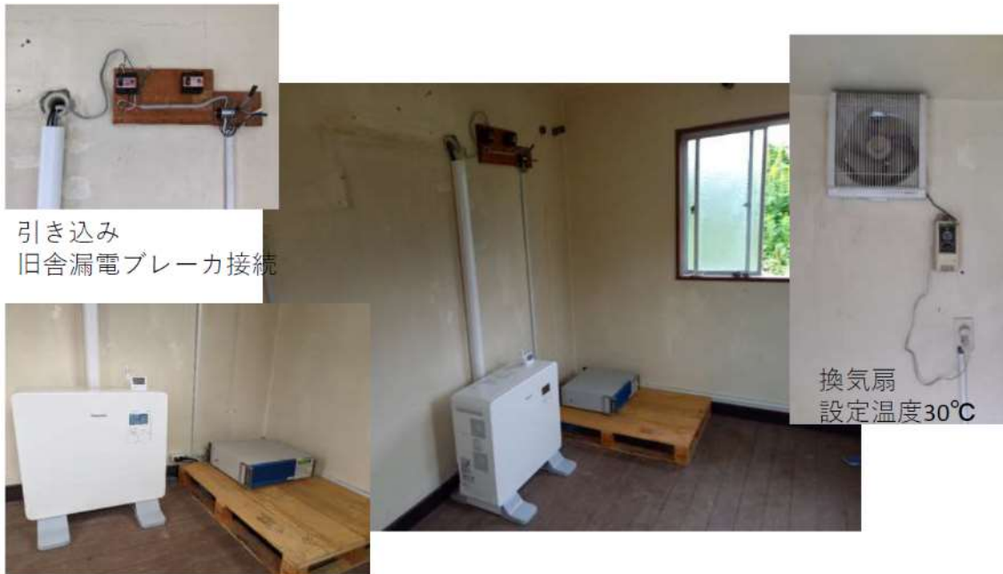
蓄電システム、電子負荷、おんどとり
