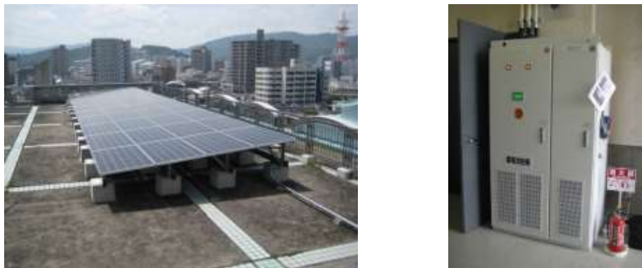
図 2-1-1 岩国総合庁舎設備写真（左：太陽光発電システム、右：蓄電池システム）
