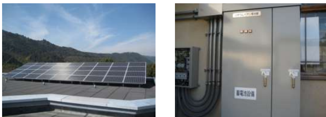
図 2-1-2 岩国高校設備写真（左：太陽光発電システム、右：蓄電池システム）
