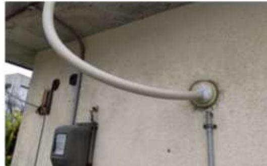
図 3-2-3 工事内容（大気測定局舎—旧舎間配線工事）
