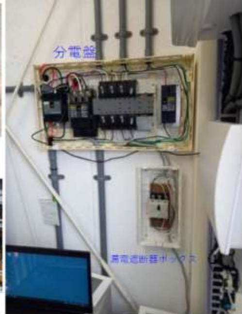
分電盤と漏電遮断器接続
