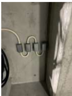
<防災用コンセント>
