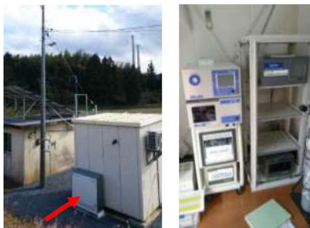
図 3-1-2 既存の蓄電池設置位置 (左) および大気測定局内部 (右)
