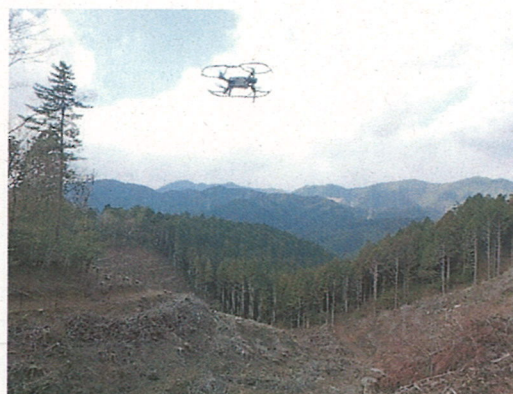
ドローンによる現場管理
