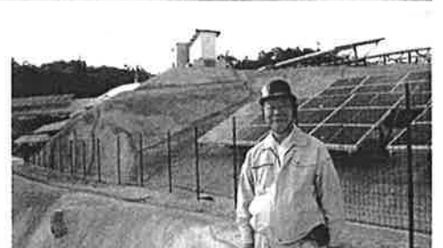
10月27日 下小鯖太陽光発電現場視察
