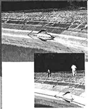
選挙区外のため池ですが、のり面に巨大な穴が開いていましたので、先ずは調査を依頼。梅雨時期ではなく良かったです。
