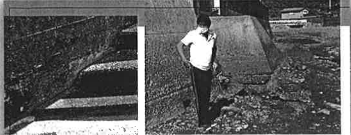
7月20、21日富海の漁港の堤防に段差が出ていますとご連絡いただき、和田市議とともに現地を調査。湾内から確認すると多くの亀裂が原因の様子。県土木、市役所の皆さん、急な依頼にもかかわらず協力ありがとうございました。
