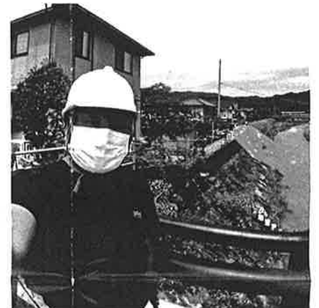
周東町東川 護岸損傷状況視察
