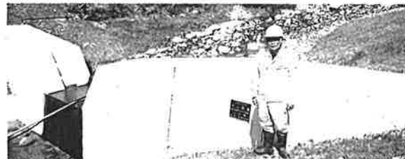
治山ダム完成_周東町_坊ヶ迫にて
