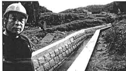
周東町椎尾川 護岸復旧
