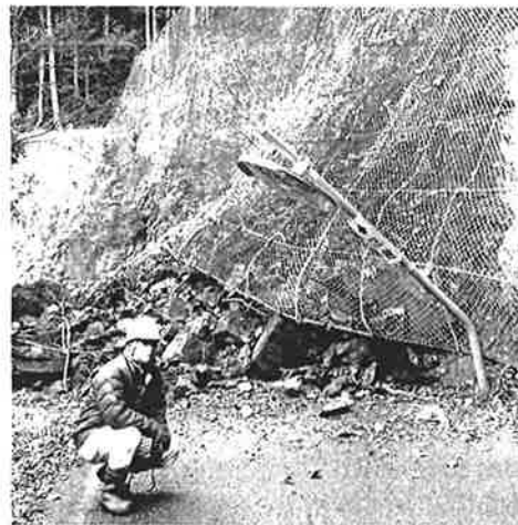
周東美川線土砂崩れ視察
