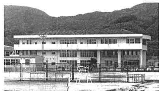
周防大島中学校校舎（旧久賀中）
