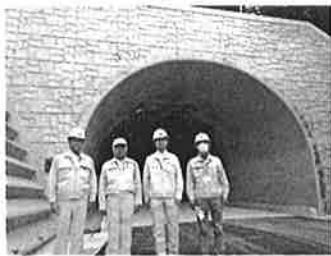
完成した「佐連アワサンゴトンネル」
