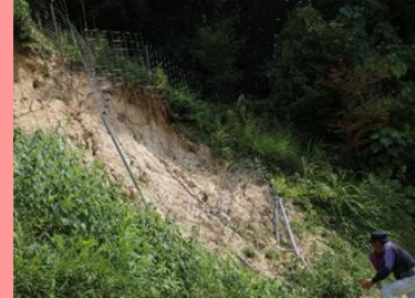
防護柵の点検（平成30年西日本豪雨により損壊）
