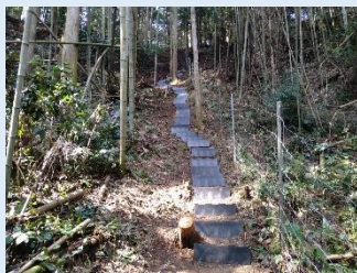
柵下部の補強
