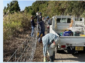
町道沿い設置状況
