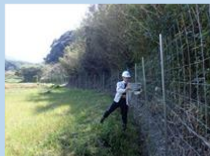
侵入防止柵の設置
