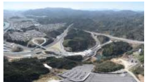
山口宇部道路小郡ジャンクション
