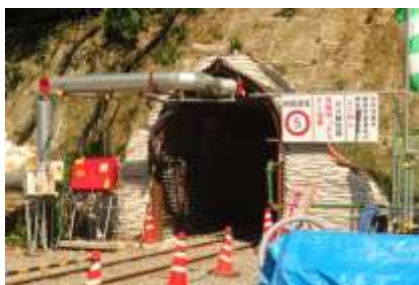
島田川工水トンネル工事（下松市）
