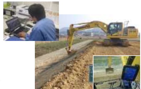
i-Constructionの取組事例 (3次元データの活用とICT建機施工による作業の効率化)
