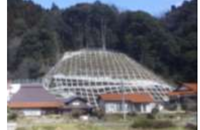
土砂災害防止施設
