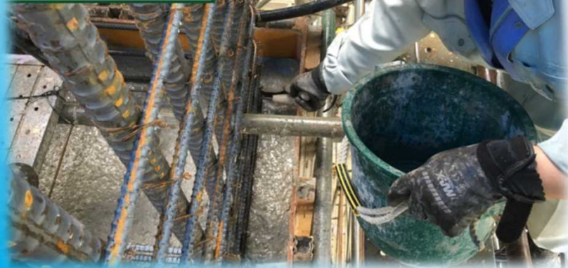
工事名 一般国道490号(小笠原道南)道路改良(平成28年度) 工種 橋脚解体工 測点 P1橋脚 柱部第4リフト ブリージング水 除去状況
