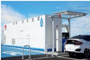
再エネ由来 水素ステーション
