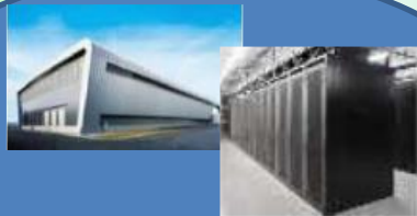
データセンター
