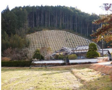
山腹工による山地災害の復旧
