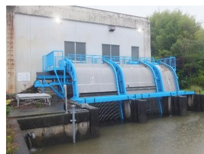
排水機場の整備
