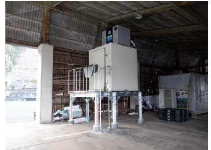
クレセントアイス製氷機の整備
