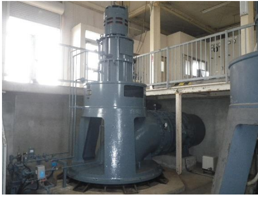
排水機場の改修 (山陽小野田市：後潟地区)
