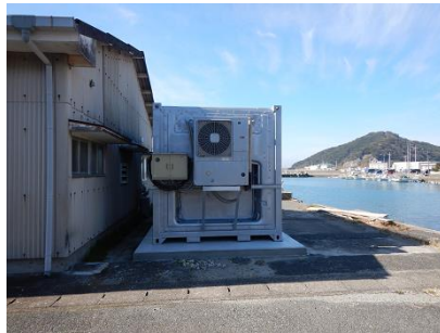
海藻保管用冷凍庫の整備
