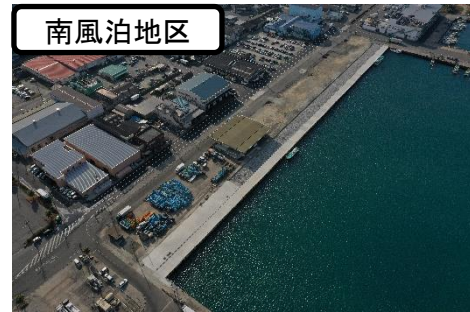
耐震強化岸壁の整備
