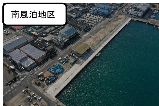
耐震強化岸壁の整備
