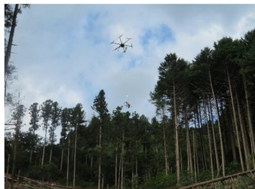
ドローンによる架線資材の運搬
