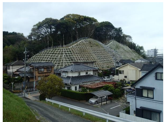
山地崩壊を予防する山腹工 (山陽小野田市大字小野田字棚田地区)
