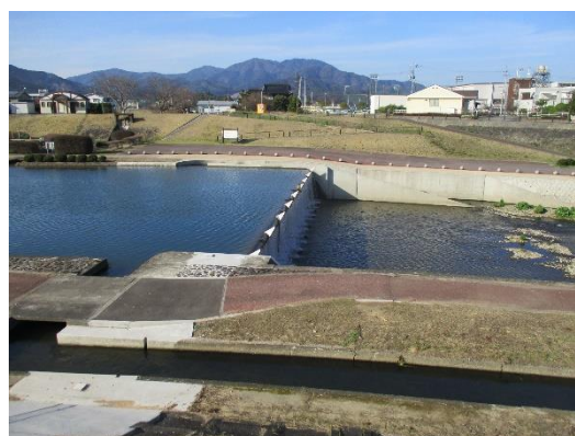
頭首工の改修 (下関市：田部大井堰)
