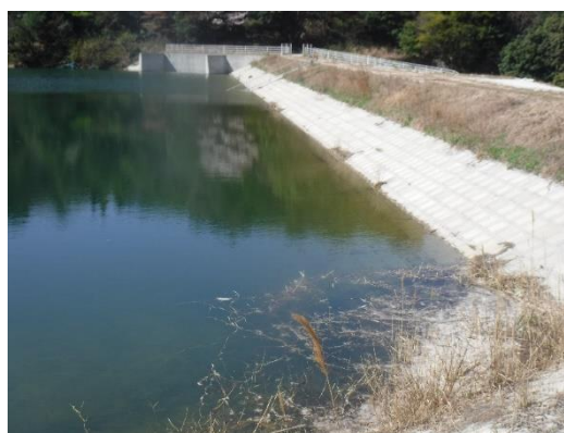
ため池の改修 (防府市：大谷口ため池)
