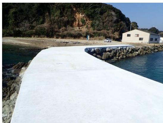
工事完成後（肥中漁港）
