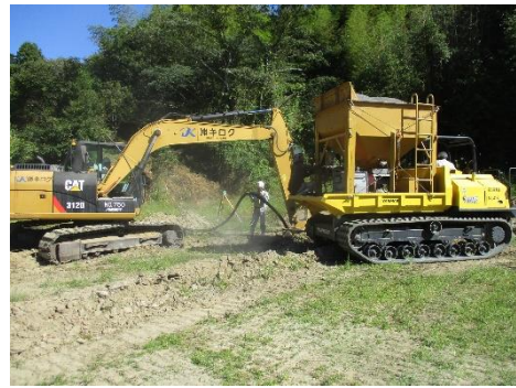
フォアス施工による水田高機能化 (下関市：王喜東地区)
