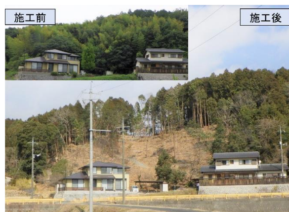
繁茂・拡大した竹林の伐採（岩国市）
