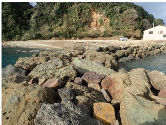
工事着手前（肥中漁港）
