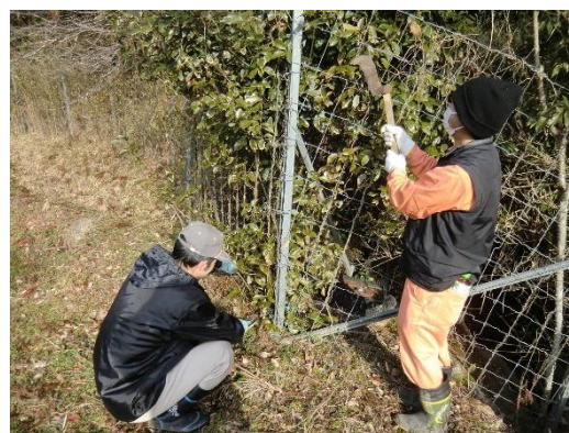
獣害防護柵の点検・補修作業 (中山間地域等直接支払：下関市)
