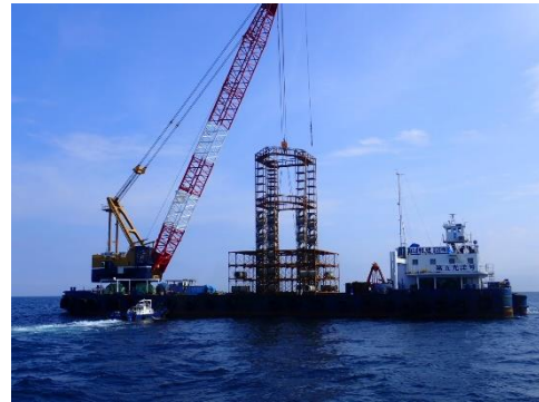
鋼製魚礁設置状況
