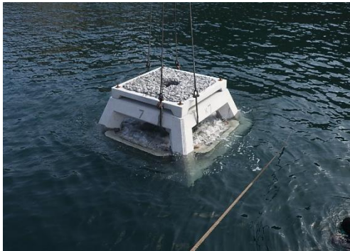
魚礁設置状況
