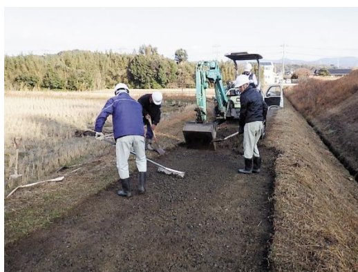
直営施工による農道舗装工事 (多面的機能支払：山口市)
