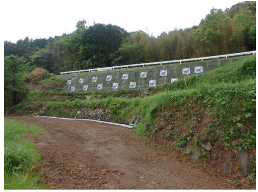
地すべり抑止工・抑制工の実施 (長門市：野田南2期地区)
