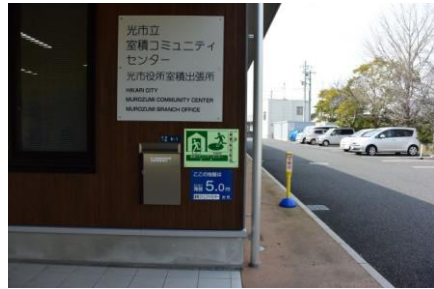
▲避難所・緊急避難場所表示板
