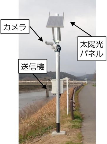
▲河川監視カメラ
