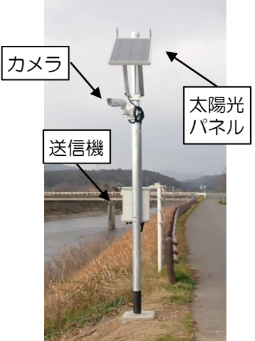
▲河川監視カメラ
