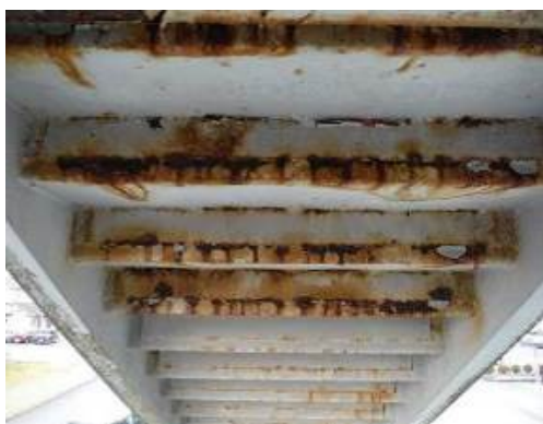
<階段部の損傷状況>
