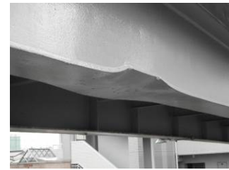
主桁：変形
