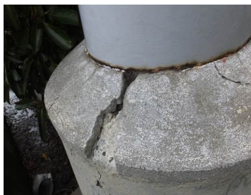
<下部構造の損傷状況>
