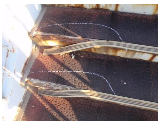
<階段部の損傷状況>
