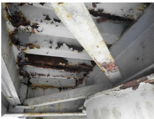
<上部構造の損傷状況>
