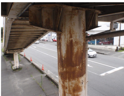
<下部構造の損傷状況>
