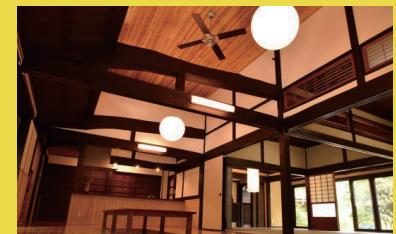
和室を LDK に改修、古い天井を取り除き隠れていた大きな梁をみせるようにした。高い位置に窓を設け、以前は暗かった北側の部屋に適度な明るさを確保した。
