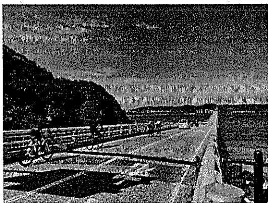
サイクリング（下関市：角島大橋）
