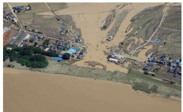
堤防決壊による家屋の流失(鬼怒川)
