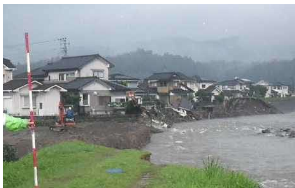
河岸侵食による家屋の倒壊(花月川)
