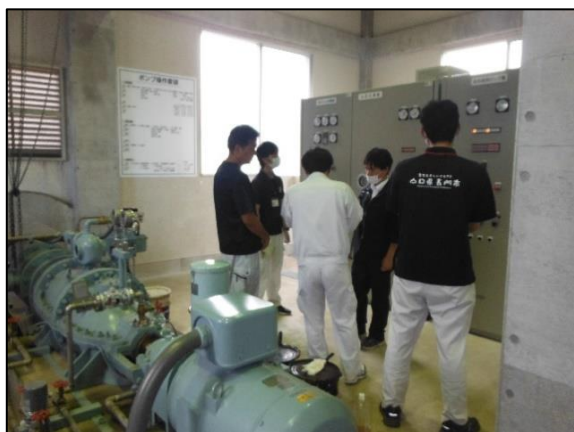
排水ポンプ整備（三隅地区）
