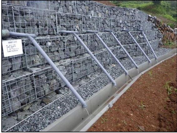
水抜きボーリング (中の森 2 期地区)
