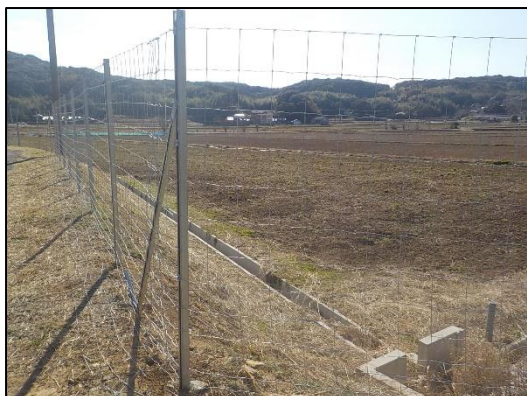
獣害柵設置状況 (本郷地区)
