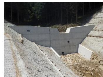
治山ダムの整備
