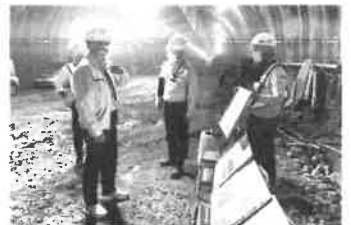
木与防災道路工事、視察・見学進捗状況の確認へ行きました。 8月22日
