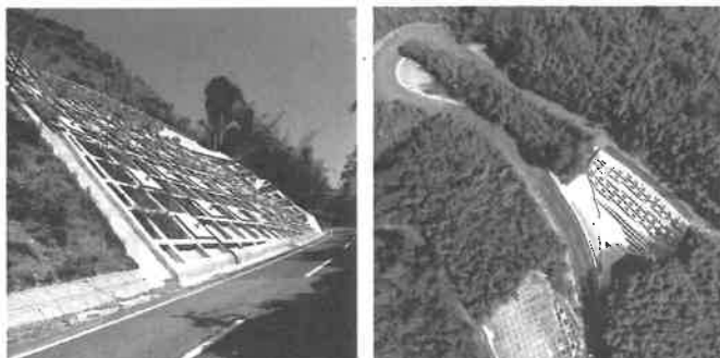
銭壺山公園線（由宇町地内） 災害復旧工事
