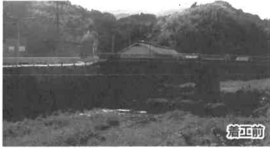
通津川 浚渫工事
