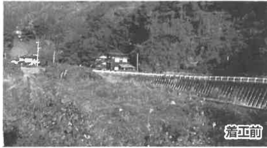
由宇川 災害復旧 工事
