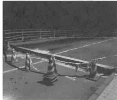
上関大橋桁端部 段差復旧工事
