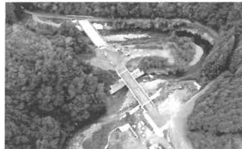
徳山本郷線橋梁工事
