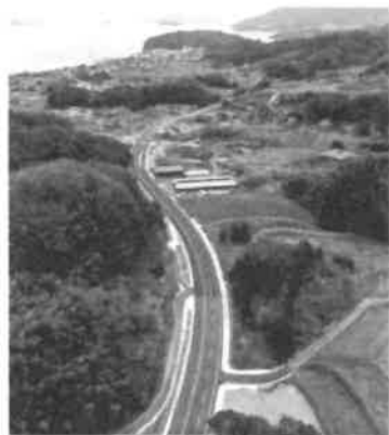
部分開通した県道柳井上関線伊保庄バイパス
