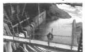
愛知県工業用水王水事故 明治用水頭首工の仮設ポンプの設置の様子 (東海農政局HPより)
