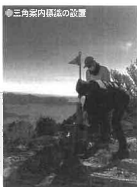
●三角案内標識の設置
