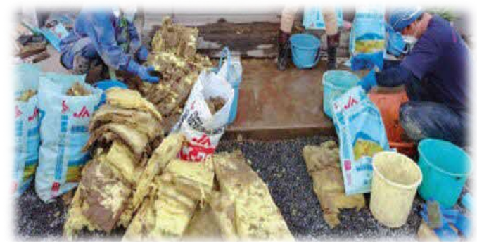
浸水したグラスウール
