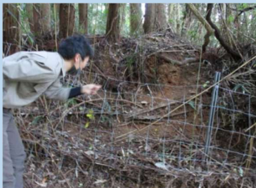
既設侵入防止柵の点検
