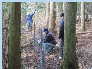
侵入防止柵の補修
