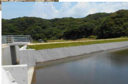
防災重点農業用ため池
