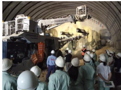
工事現場見学会
