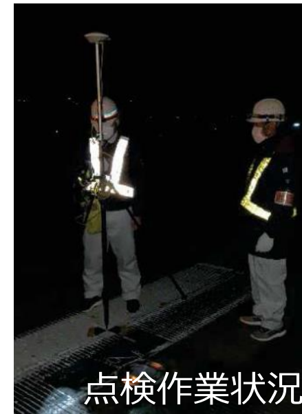
点検作業状況
