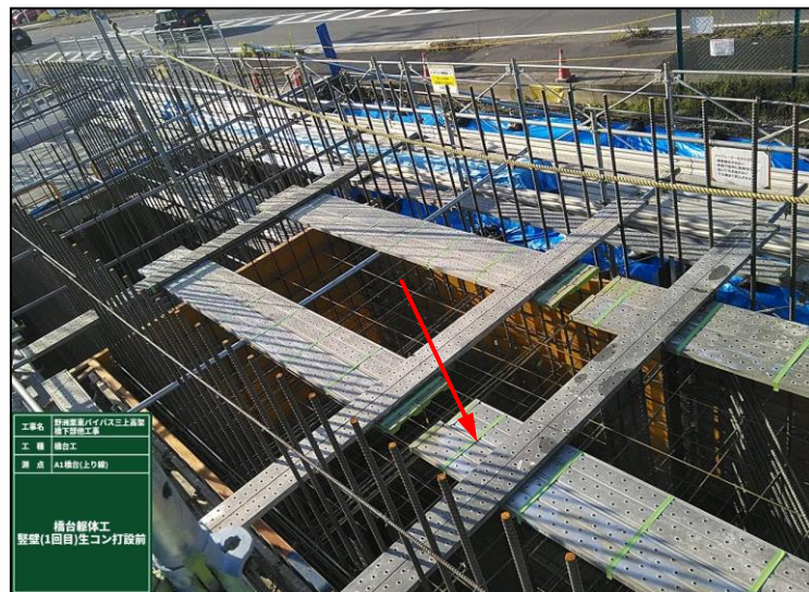
締固め間隔の明示(@500mm)
