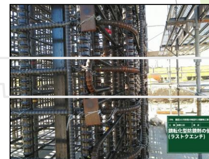
【曲げ加工部の錆処理完了】 (ラストクエンチによる処置後)
