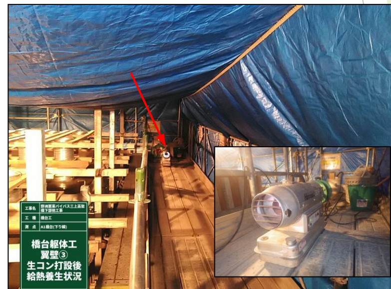
ジェットヒーターによる給熱養生
