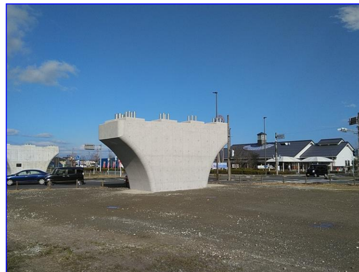
完成(P13橋脚)
