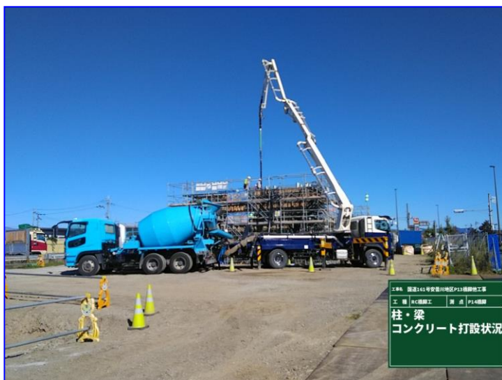
柱・梁部生コン打設状況
