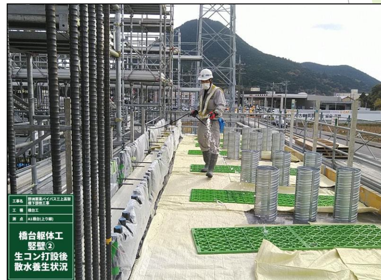
A1橋台 堅壁天端部散水養生
