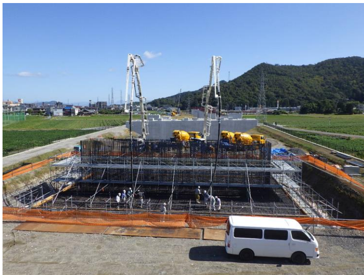
橋脚フーチング部コンクリート打設
