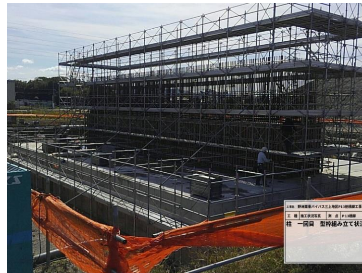
橋脚柱部型枠組立
