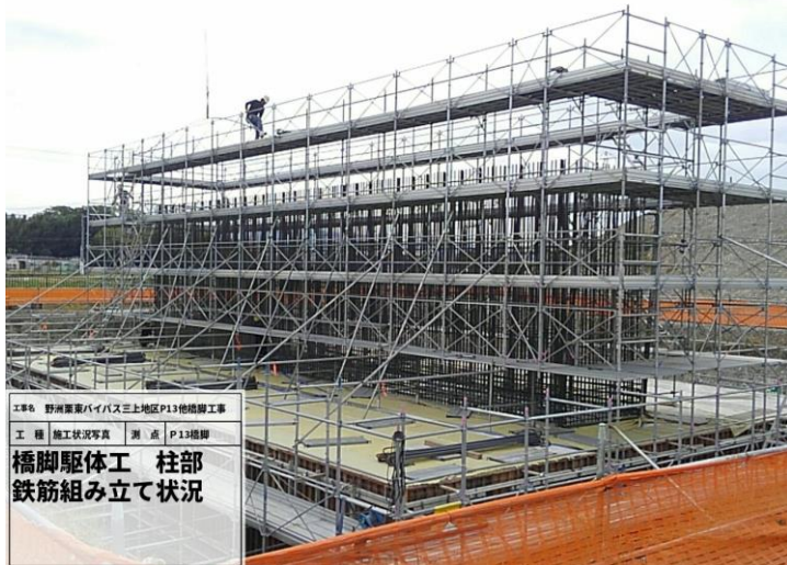
橋脚柱部鉄筋組立
