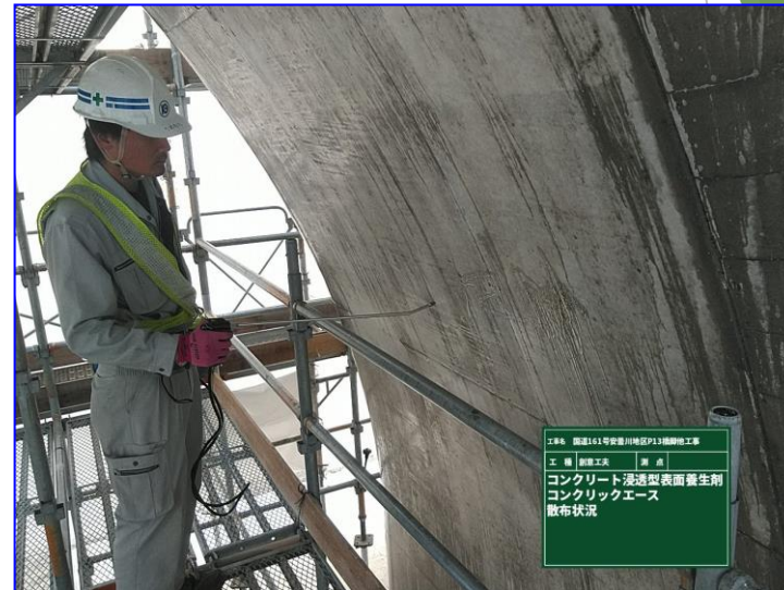
コンクリート養生（含浸型表面養生剤）
