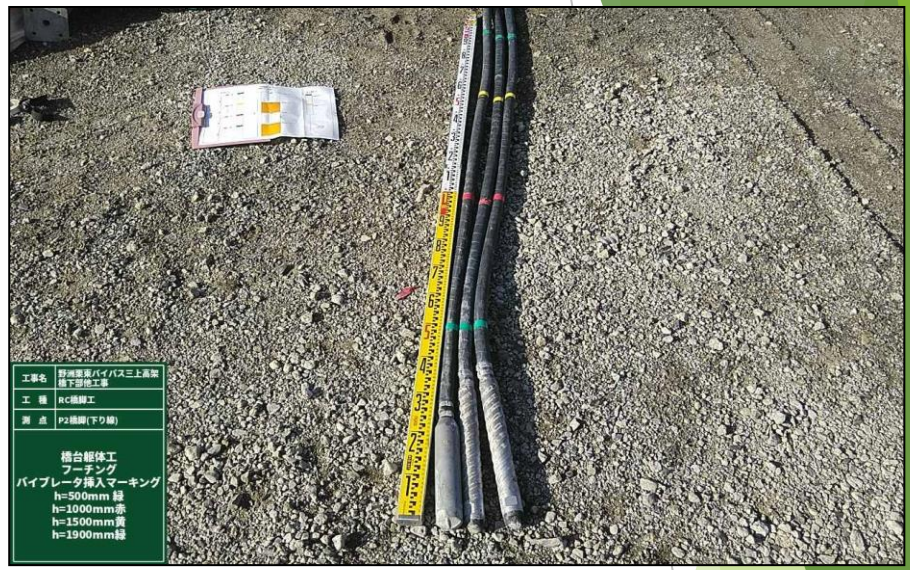
バイブレーター挿入深さの明示(100mm挿入)
