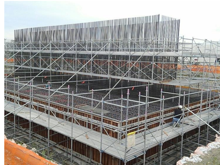
橋脚柱部型枠組立
