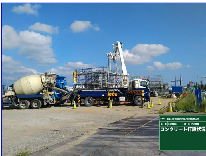
フーチング部生コン打設状況
