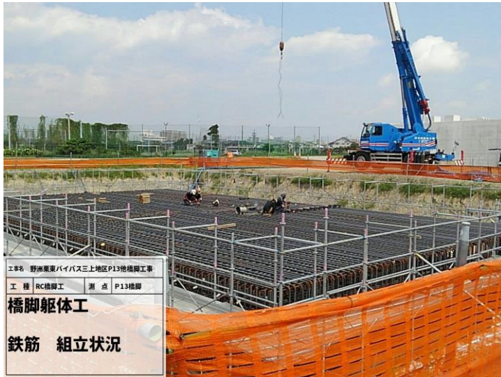
橋脚柱部鉄筋組立
