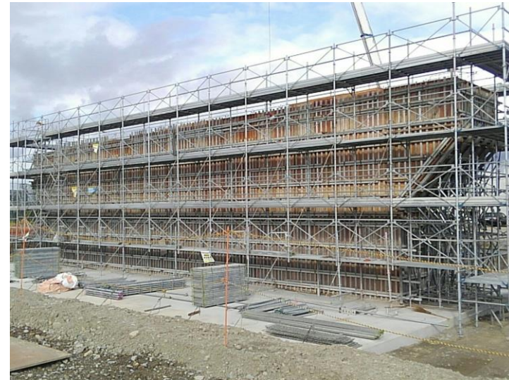
橋脚躯体部コンクリート打設
