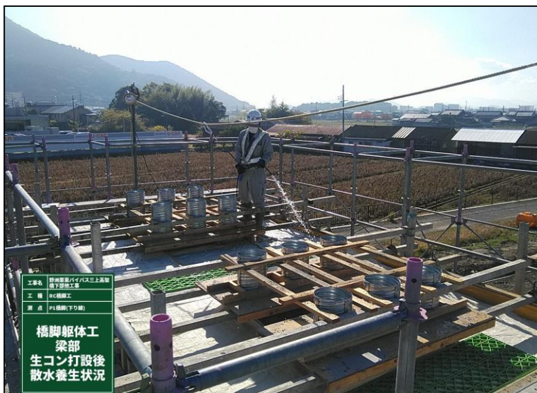
P1橋脚 梁天端部散水養生
