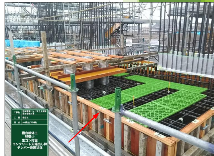
締固め間隔の明示(@500mm)
