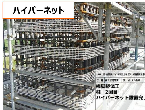
補強鉄筋
