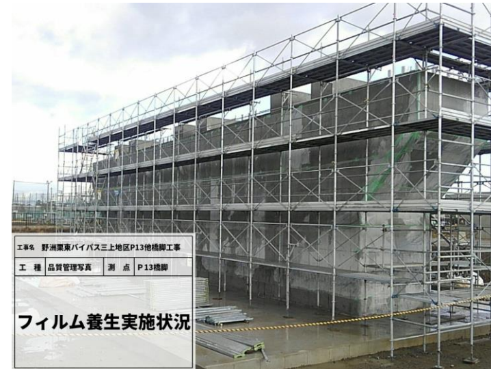
コンクリート養生（表面封緘養生）
