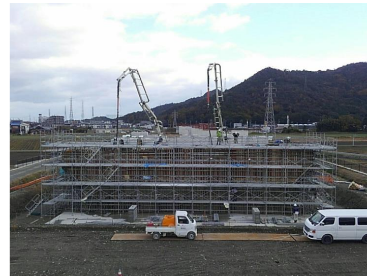
橋脚躯体部コンクリート打設
