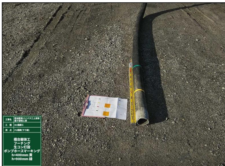
ポンプ車のホースにマーキング
