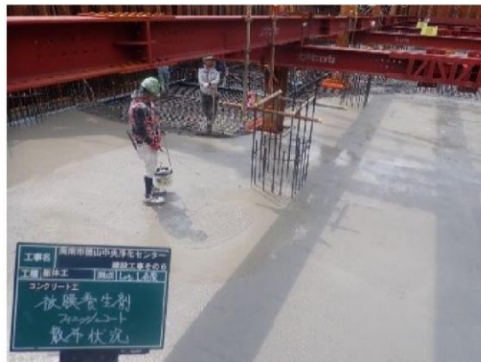
上面の被膜養生剤散布（フィニッシュコート）
