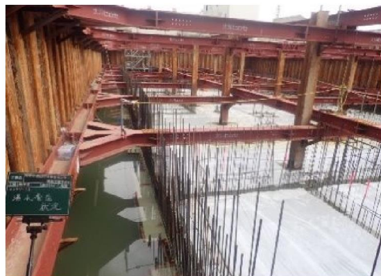
底版部湛水養生 (養生期間中水替えの停止)
